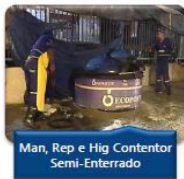
Figura 131: Foto da operação de Manutenção do Contentor Semienterrado
