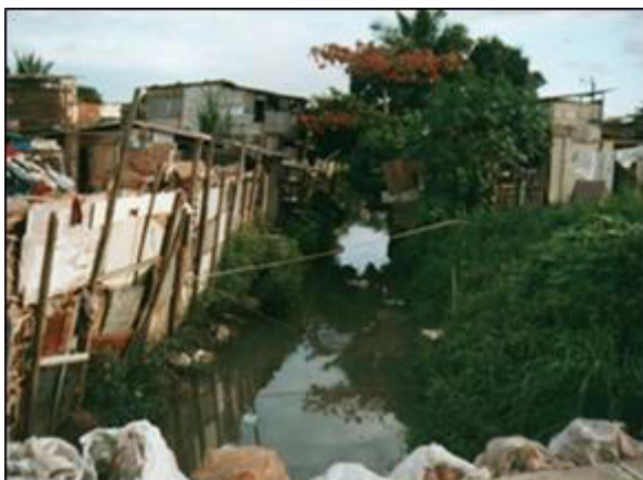
Foto 21: Vista do Canal da Barriguda
