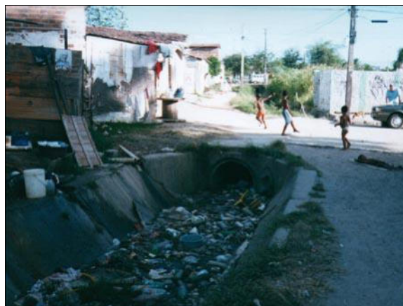
Foto 24: Lixo no Canal do Torreão
