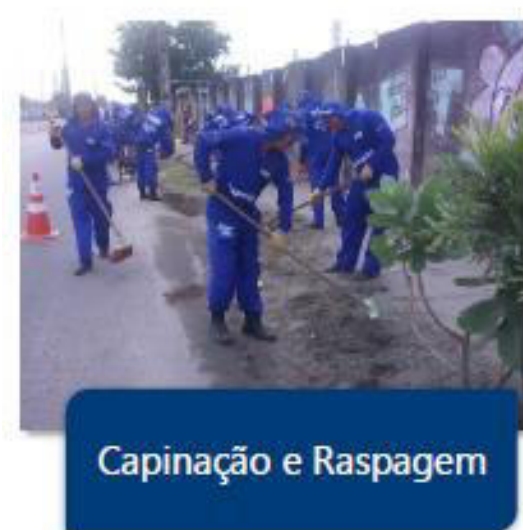
Figura 110: Foto da Realização dos Serviços de Capinação e Raspagem
