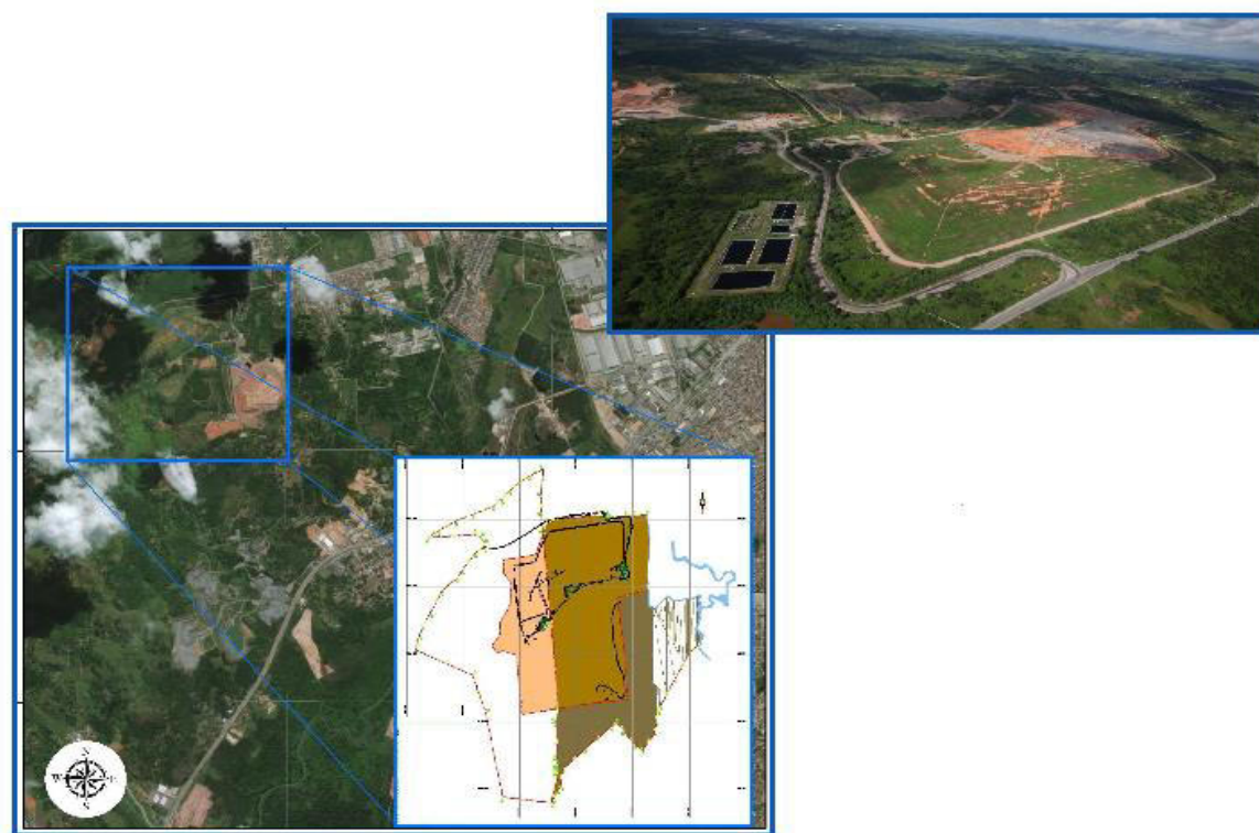
Figura 136: Foto do Aterro Sanitário de Muribeca
