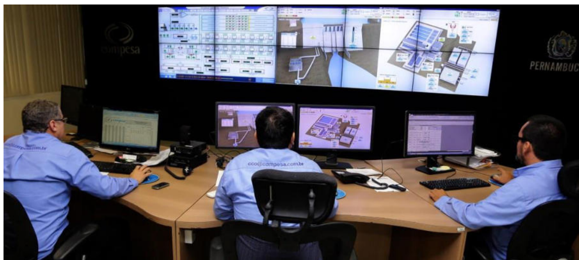
Figura 33: Imagem do Centro de Controle Operacional
