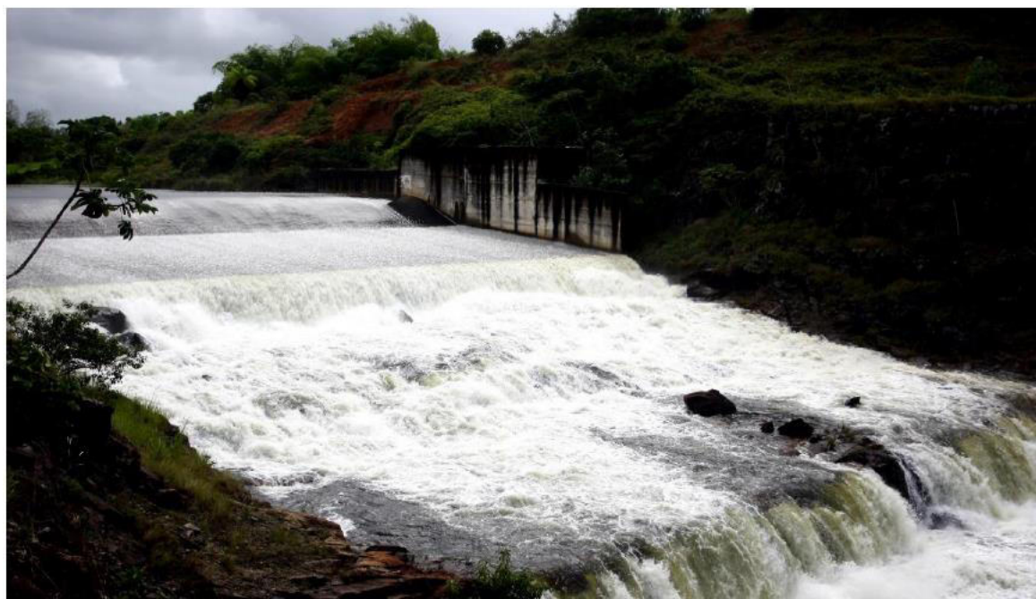
Figura 34: Extravasar da Barragem de Pirapama no Cabo de Santo Agostinho – Barragem de Melhor Rendimento Hidrológico da RMR
