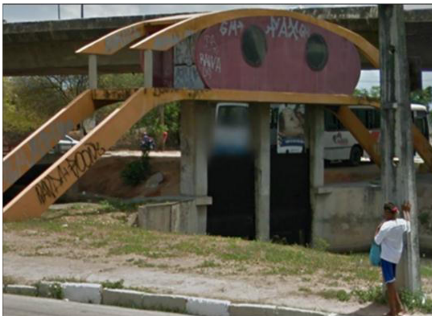
Foto 33: Comporta da Extremidade Norte do Canal Derby-Tacaruna
