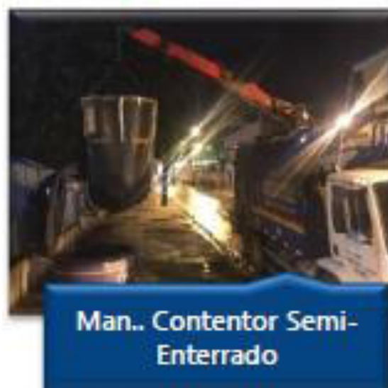
Figura 130: Foto da Operação de Implantação de Contentor Semienterrado
